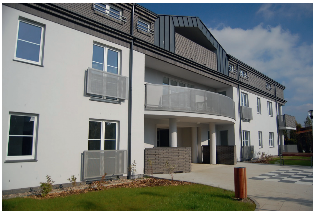
Środowiskowy Dom Emeryta w Poznaniu, lokale mieszkalne w Poznaniu przy ul. Drewniańskiej, fot. PTBS Sp. z o. o.
